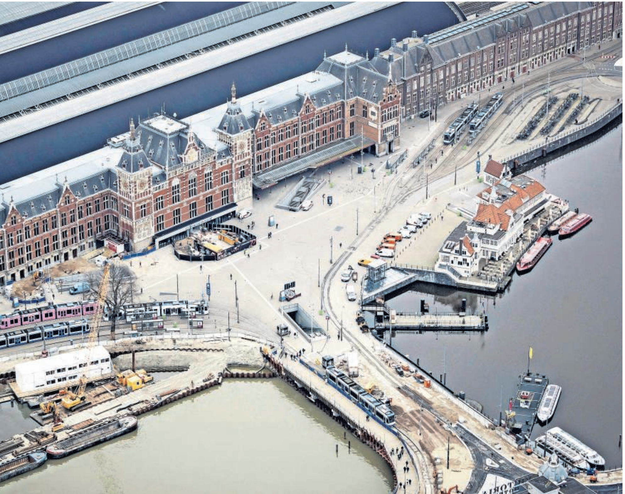
Bouwproject bij het Centraal Station in Amsterdam. FOTO ANP
